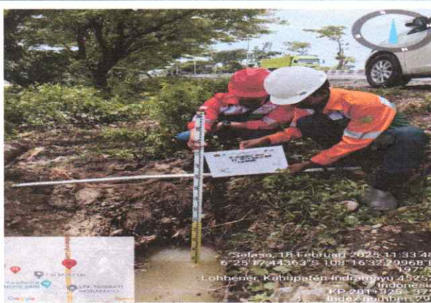
Judul Foto Pengukuran kedalaman lubang dari atas subduct Tanggal 18 Februari 2025 Loc KP 281+900-KP 281+235
