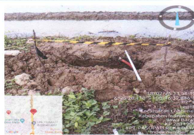
Judul Foto pemasangan Baricade pada pit Tanggal 18 Februari 2025 Loc KP 281+900-KP 281+235
