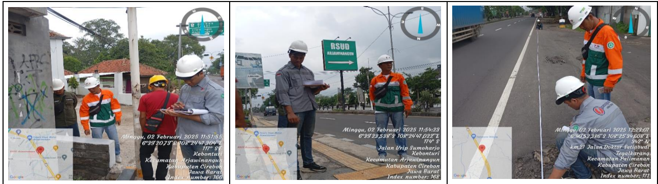
Nama pekerjaan + KP.----
