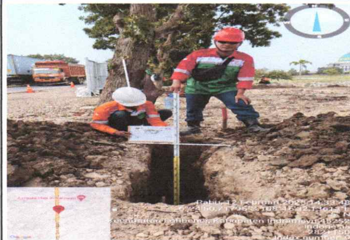
Judul Foto Pengukuran kedalam lubang Tanggal 12 Februari 2025 Loc KP 282+200
