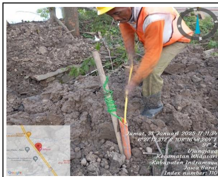
Test Menggunakan Rodder Stik KP 277+750
