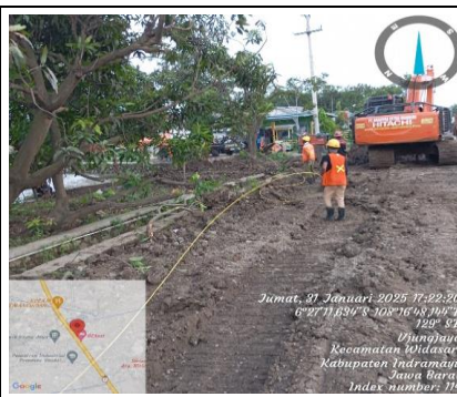
Test Menggunakan Rodder Stik KP 277+750
